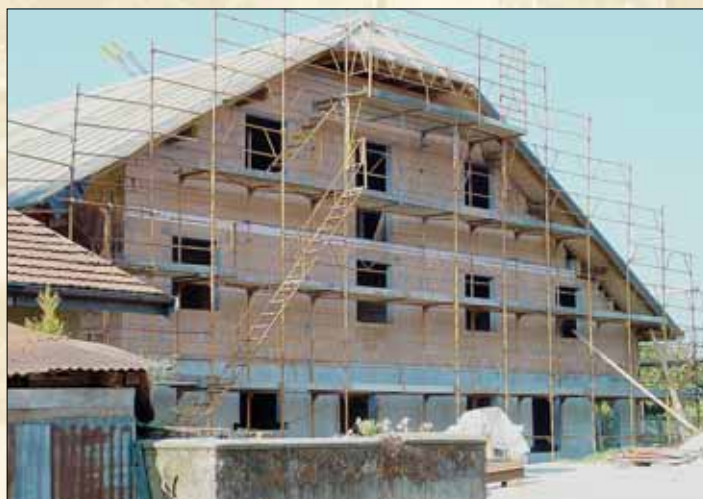
12 mois de travaux !
